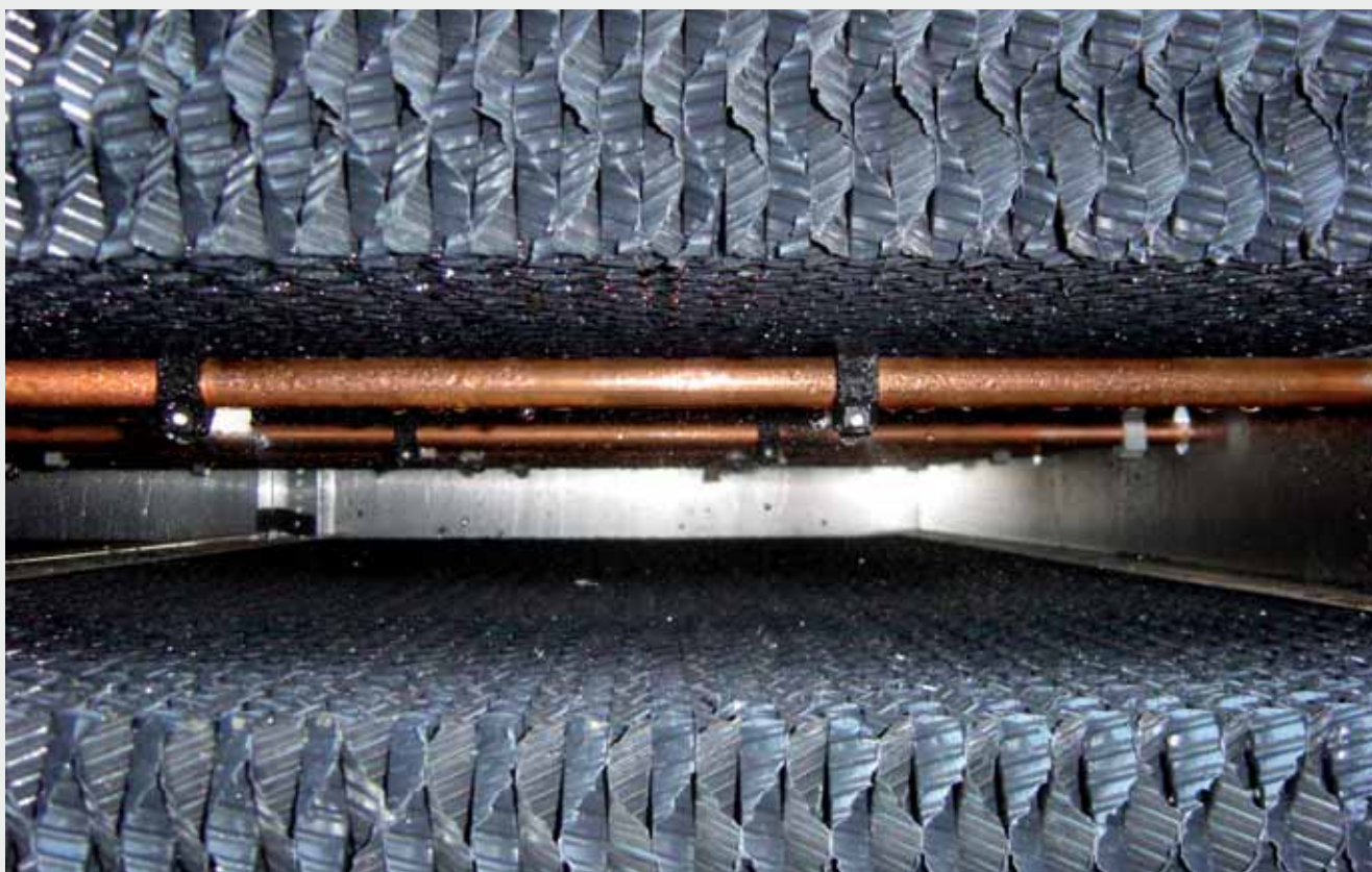
Widok zestawu zraszającego i filtrów (A) w komorze adiabatycznej.
